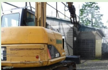
建物解体工事
